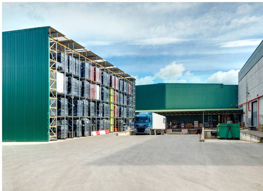
← Muelles de recepción y carga
